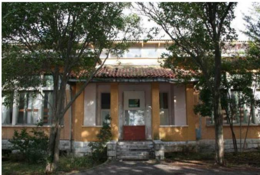
Slika 1. Glavni ulaz u zgradu, središnji dio južnog pročelja
