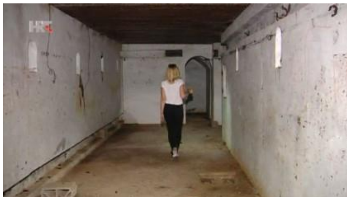
Slika 3. Unutrašnjost bunkera Fratelli Croce
